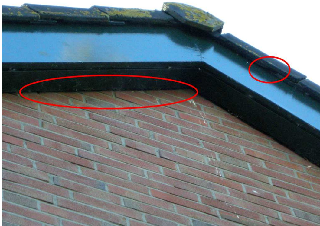
Figuur 3. Voorbeelden van potentiële invliegopeningen voor vleermuizen tussen de muur en de daklijst (links) en tussen de daklijst en de dakpannen van het zorgcentrum. De ruimte in de nok wordt waarschijnlijk als overnachtingsplek door een kleine zangvogel gebruikt. Dit verklaart de aanwezigheid van vogelpoep op de muur.
