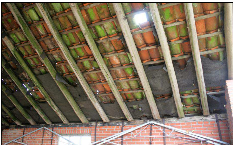
Binnenzijde kapschuren (14 oktober 2016)
