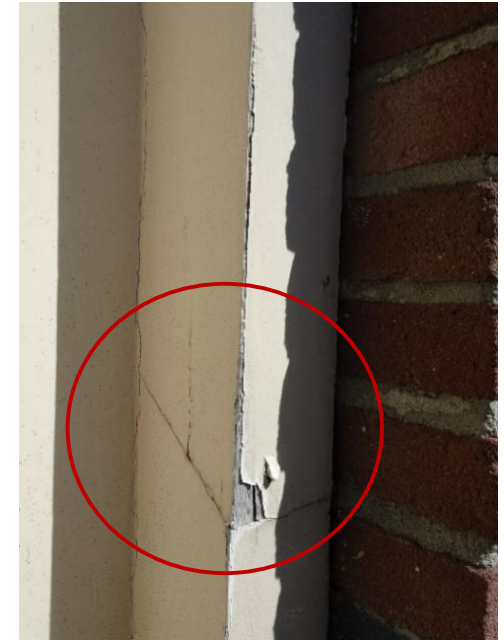
38. Las in huidige kozijn entree.
