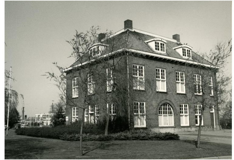
23. Foto uit 1974 toen het pand als muziekschool in gebruik was. De rondboogportiek is al vervangen door een raam, maar de huidige hoofdentree is nog niet gerealiseerd. (foto: beeldbankgroningen.nl ).
