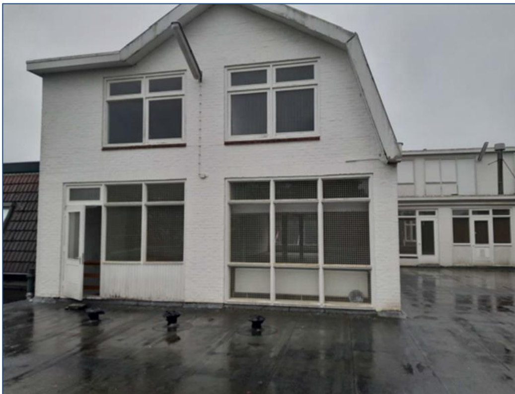
Figuur 3.6: Boven op het winkelpand is een uitbouw aanwezig.
