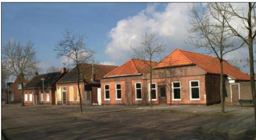
Figuur 6: Aanzicht oorspronkelijke situatie (reeds gesloopt)
