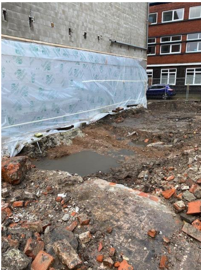
Afbeelding 2: Overzichtsfoto ten tijde van sloop oostelijk gericht ter plaatse van de Blijhamsterstraat.
