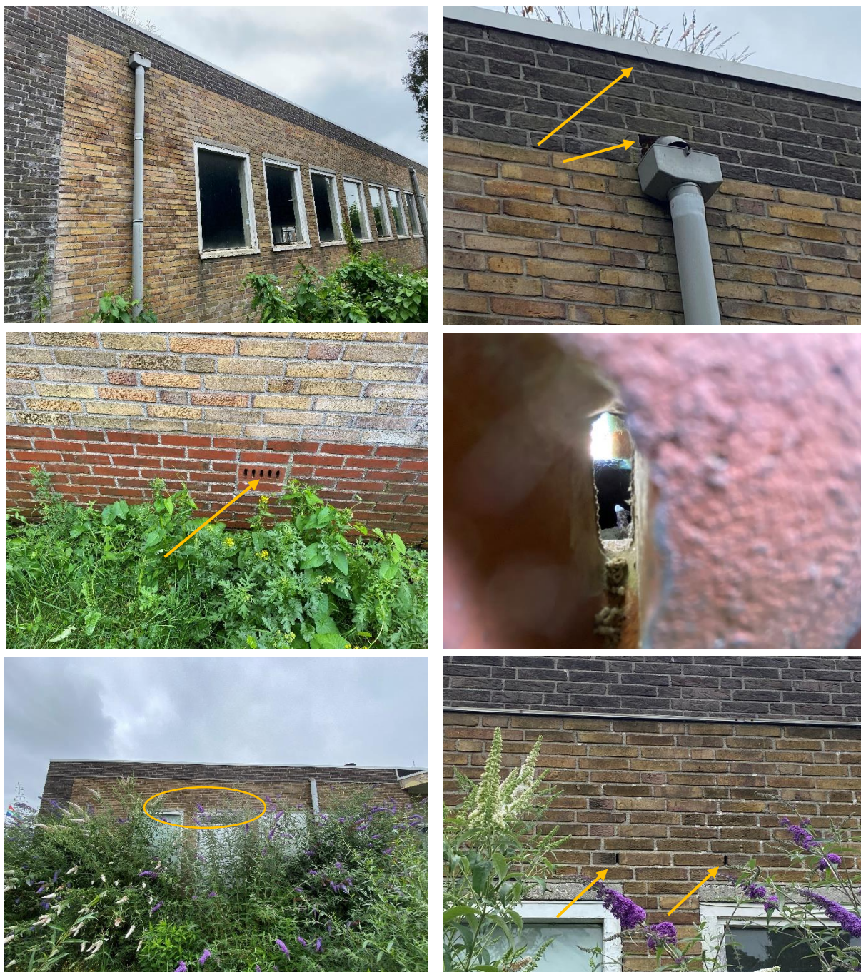
Figuur 5 Boven: opening onder daklijst en opening rondom regenpijp aan de noordkant. Midden: ventilatiesteen met een opening naar een kruipruimte aan de noordkant van het pand. Onder: open stootvoegen, geschikt voor vleermuizen, aan de zuidkant van het gebouw. De pijlen geven potentiële invliegopeningen voor vleermuizen weer. Links een overzichtsfoto en rechts een close-up. Foto's: Bureau Biota.
