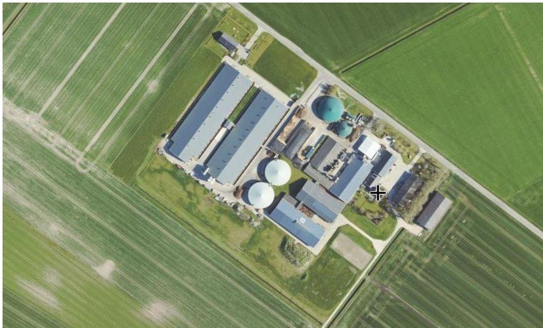
• Figuur 1: Luchtfoto locatie Ulsderweg 8-10 te Beerta
