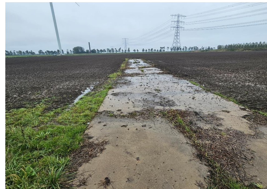
Figuur 12: Verharde landbouwweg binnen plangebied
