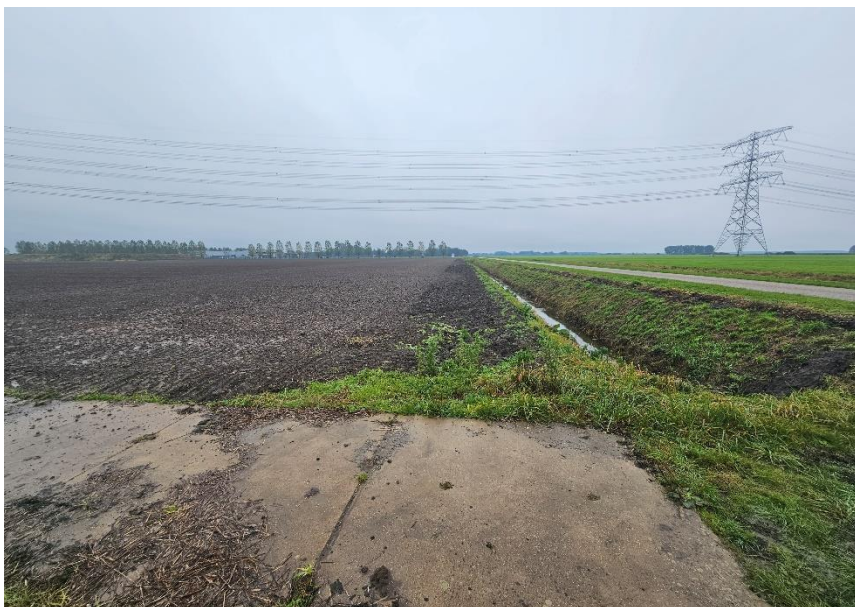
Figuur 10: Verharde landbouwweg binnen plangebied, vanuit westen
