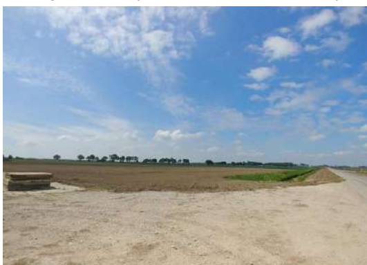
18 toegangspad windturbine in aanbouw
