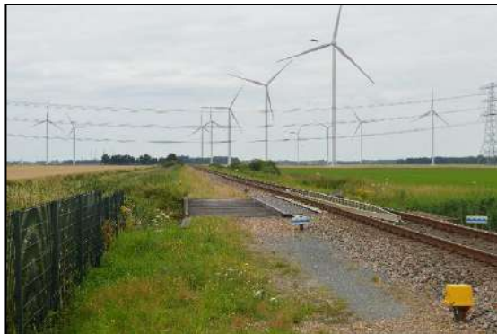
Afbeelding 2.8. Treinspoor waaronder tracé geboord wordt.
