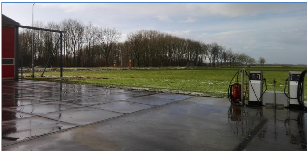
Figuur 2.5: Het plangebied, naast de bestaande hangar, waar hangar 4 is gepland .
