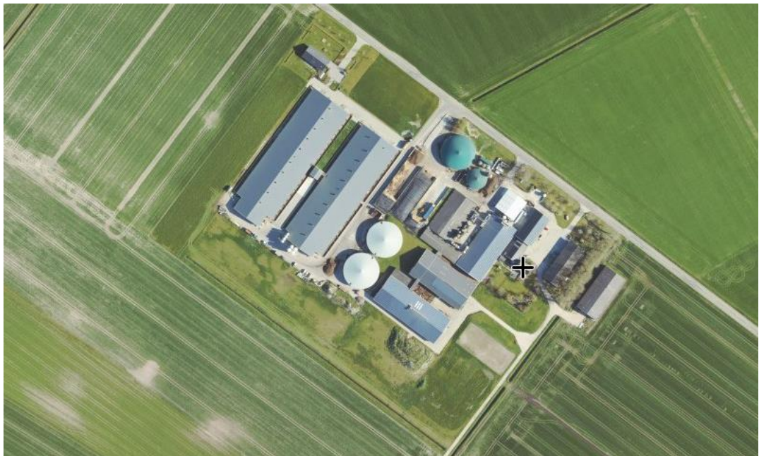
• Figuur 1: Luchtfoto locatie Ulsderweg 8-10 te Beerta
