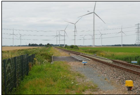
Afbeelding 2.8. Treinspoor waaronder tracé geboord wordt.
