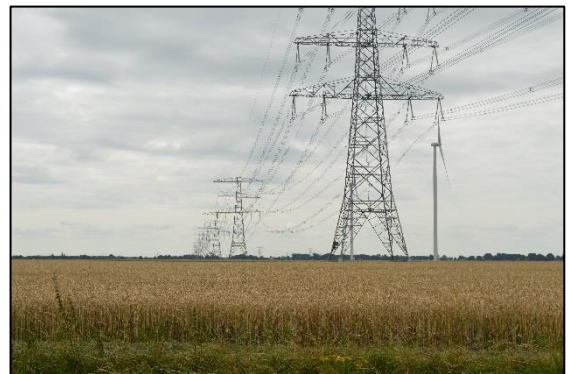
Afbeelding 2.9. Plaats waar tracé door een perceel loopt, gezien vanaf noorden vanaf fietspad langs treinspoor
