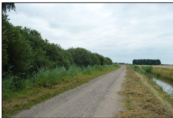
Afbeelding 2.10. Fietspad langs treinspoor waar tracé onder geboord wordt.
