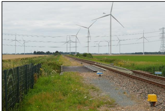
Afbeelding 2.8. Treinspoor waaronder tracé geboord wordt.
