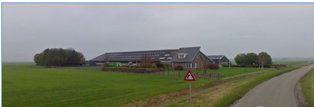
Fig. 2.4: Weergave van het plangebied gezien van de zuidzijde van het perceel.
