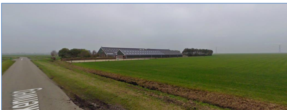
Fig. 2.5: Weergave van het plangebied gezien vanaf de noordzijde waar de gewenste stalruimte gerealiseerd wordt.
