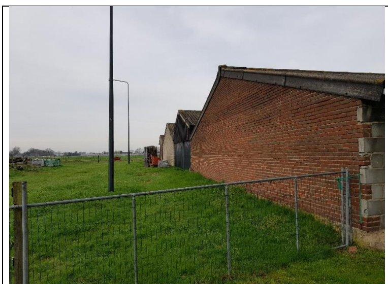
foto 5: onderzoekslocatie gezien vanuit het oosten (13 april 2018)
