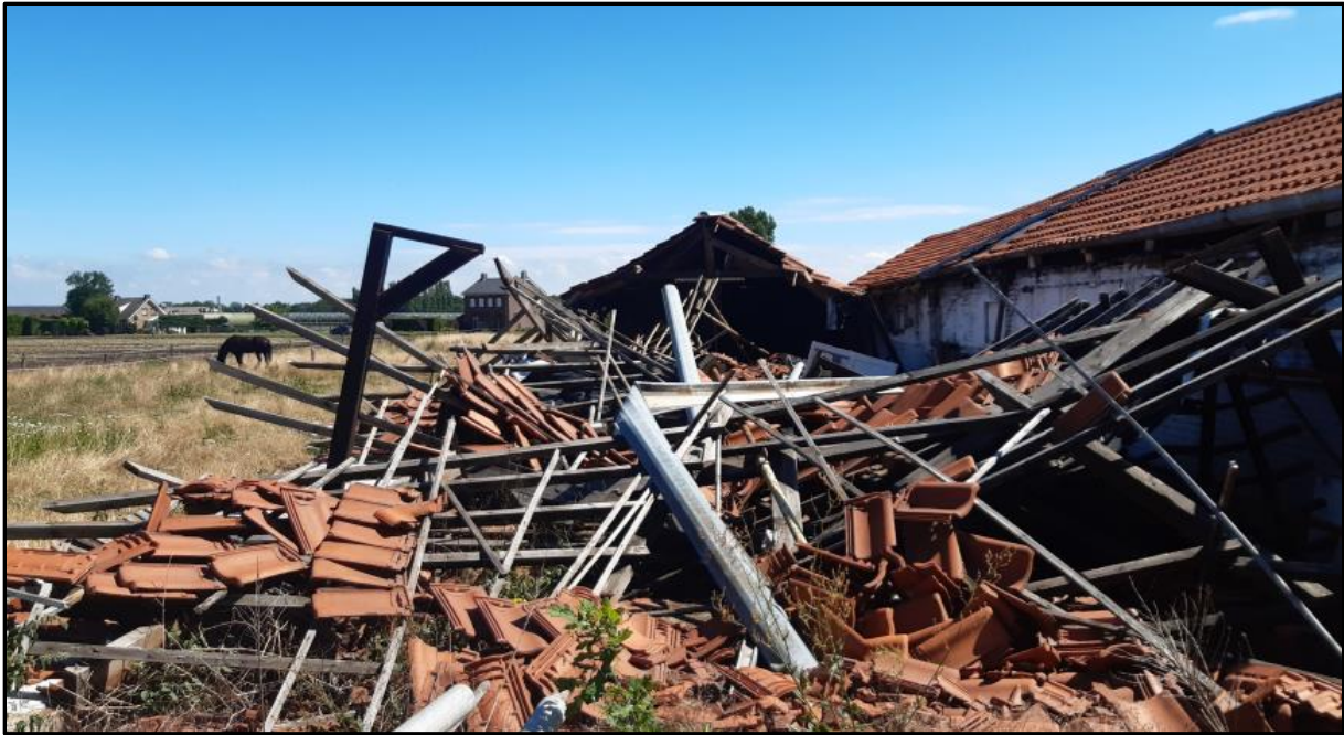
Afbeelding 8: foto te slopen bebouwing
