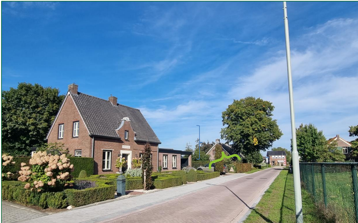
Afbeelding 5. Zicht op de bestaande woning Jan Thijssensteeg 5 met aan de rechterzijde de projectlocatie
