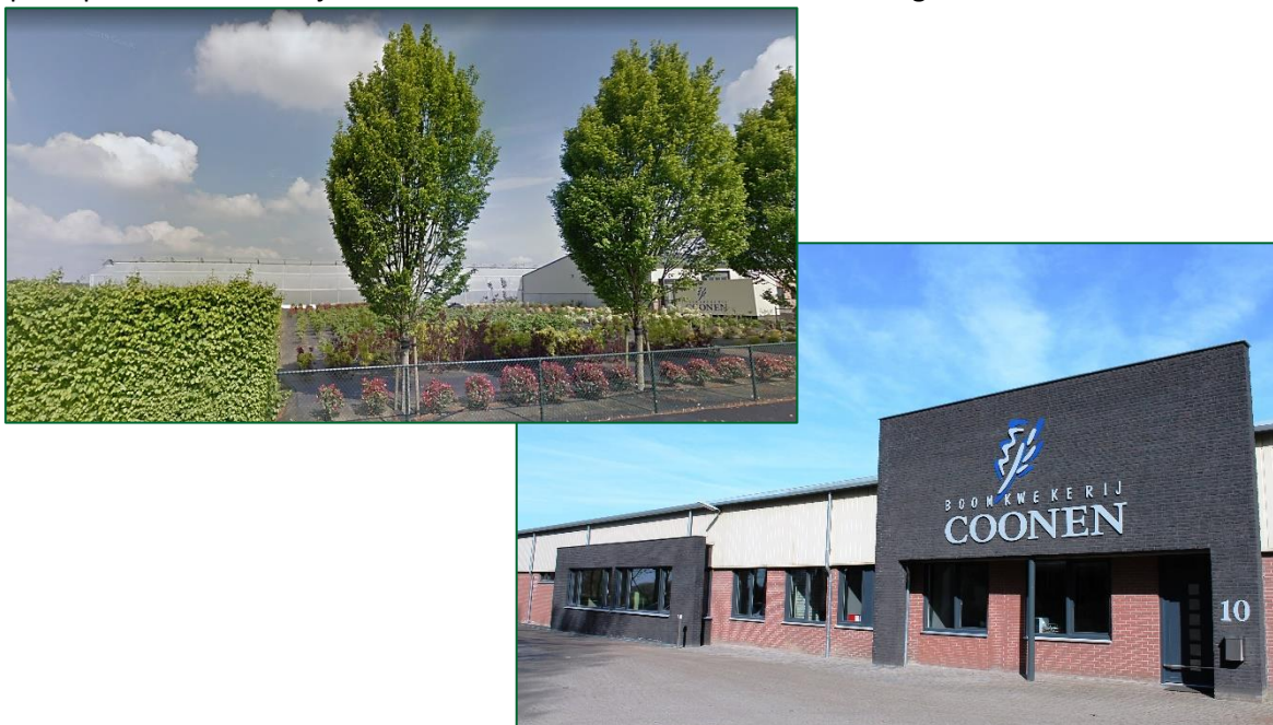
Afbeelding 6 en 7. Doorzicht naar de bestaande foliekas in Kessel en voorzijde bedrijfsloods Op den Bosch 10 – aandacht voor ontwerp en materiaalgebruik
