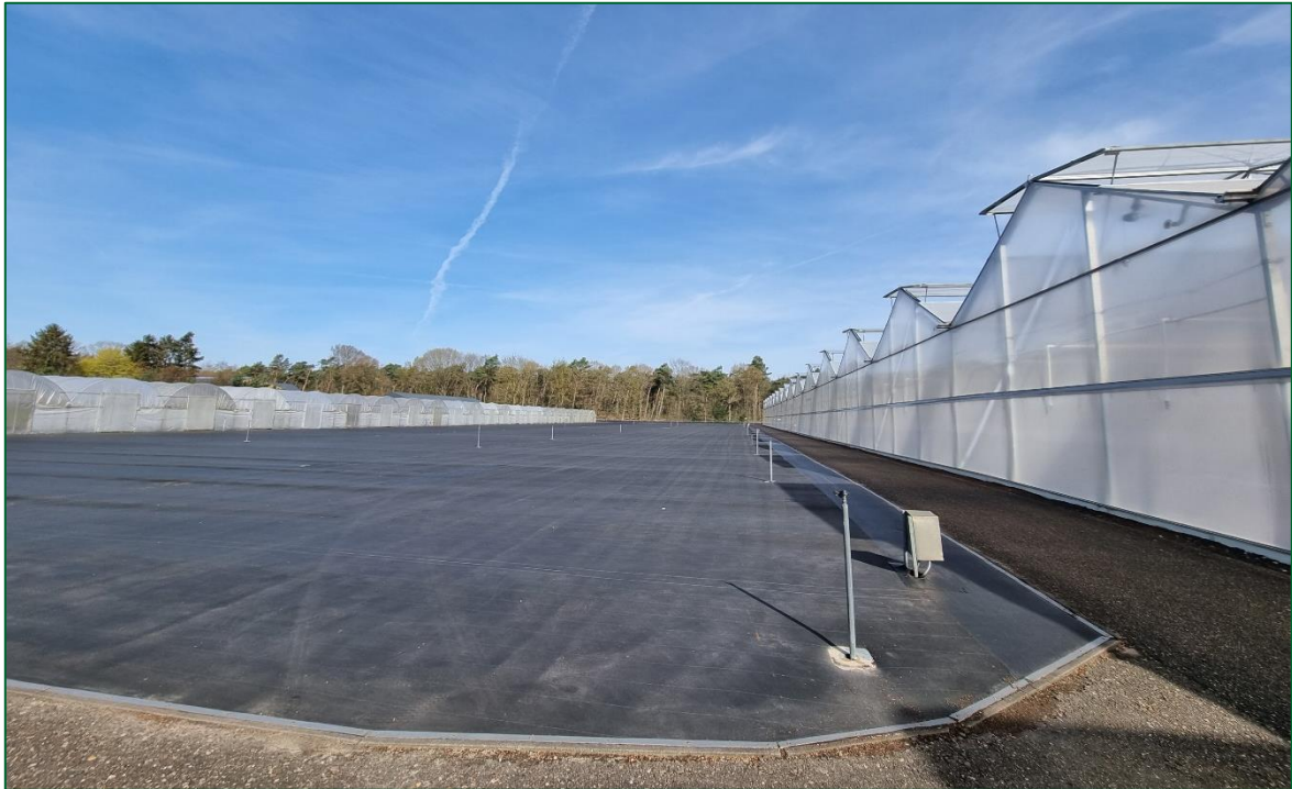
Afbeelding 11. Huidige situatie locatie 'stap A': containerveld tussen foliekas en boogtunnels
