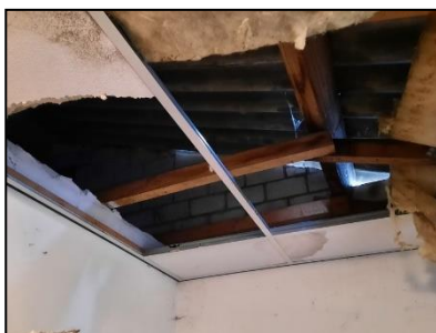
Figuur 10. Opening naar ontoegankelijke zolder van de schuur.
