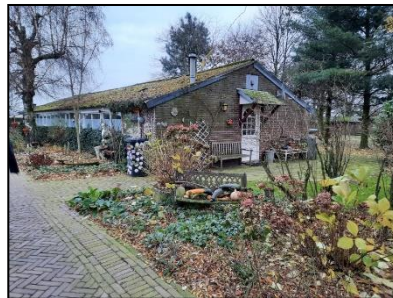
Figuur 4. Vooraanzicht van de te slopen schuur, kijkrichting noord.
