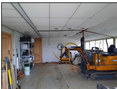
Figuur 9. Binnenzijde schuur, kijkrichting zuid.
