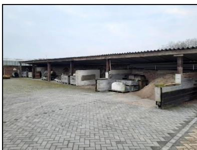
Figuur 6. Overzicht van de te slopen overkapping, kijkrichting zuidwest.
