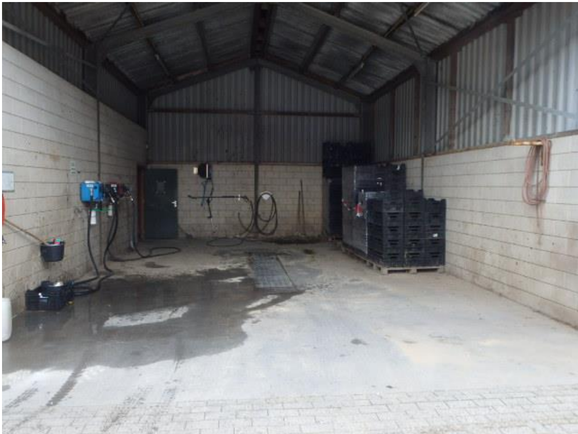
Foto 3: wasplaats met links afgiftepunten dieselinstallatie (gezien vanuit het westen, 2 september 2015)
