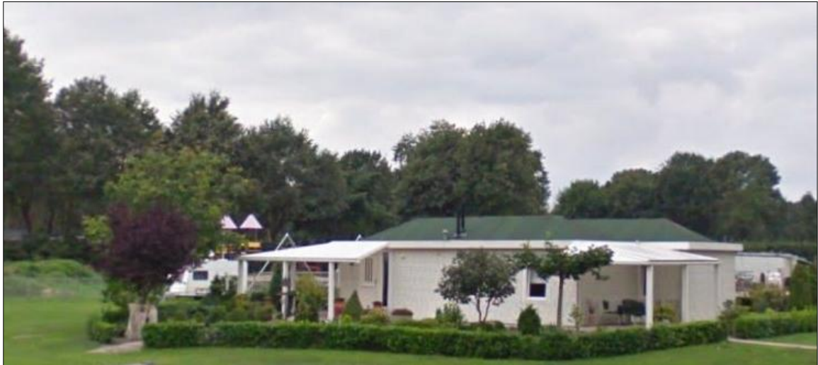
Foto bestaande situatie
