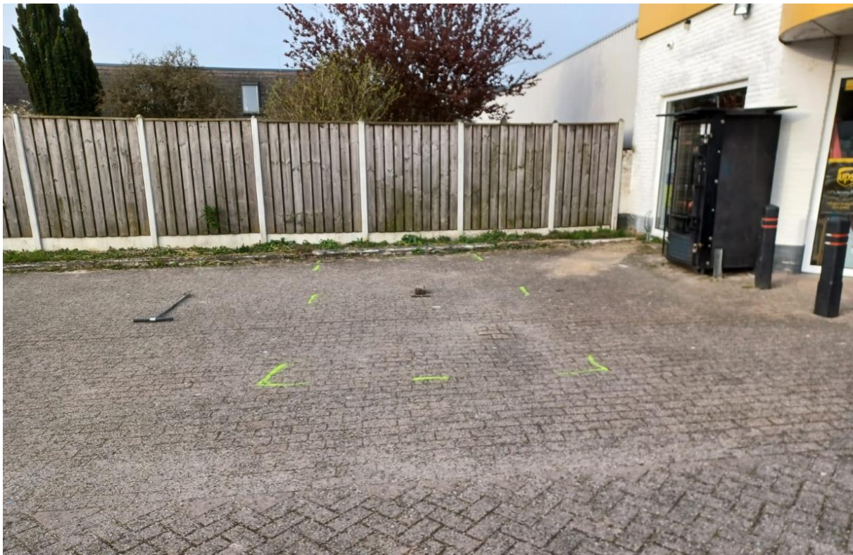
Figuur 1 Vermoedelijke ligging ondergrondse tank
