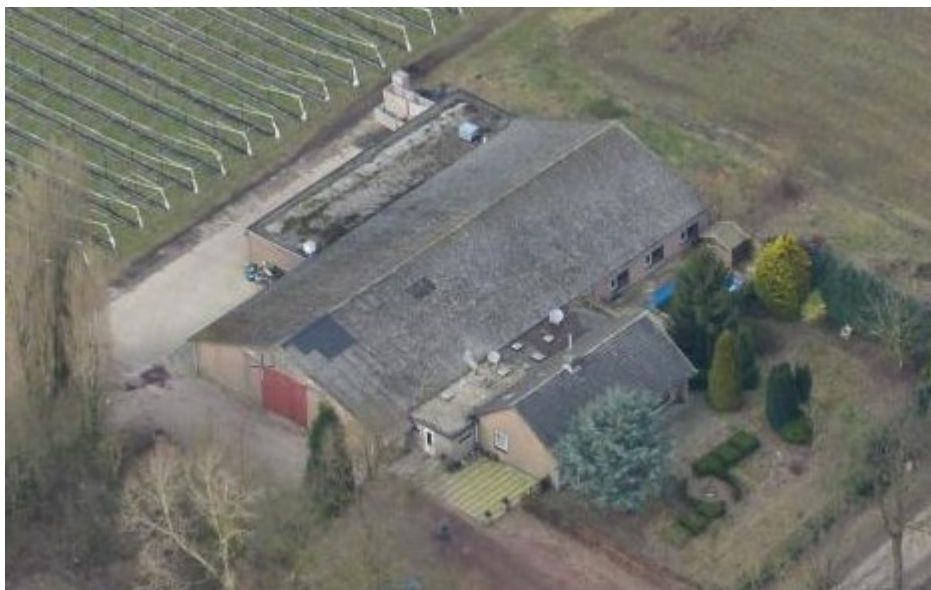
Asbestverdachte dakplaten op de loods, foto dateert uit 2013.
