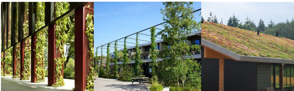
Afb. 5.4.6 – referentiebeeld begroeide pilaren (klimplanten) en afb. 5.4.7 sedumdak
