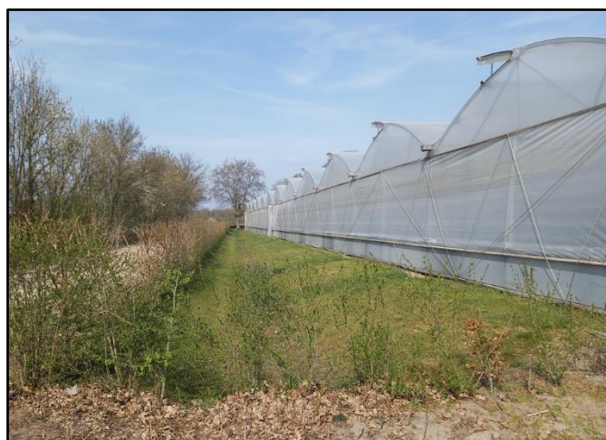
Afbeelding 20: bestaande foliekas vanuit zuidzijde gezien
