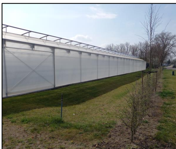
Afbeelding 19: bestaande foliekas aan zijde Baarloseweg
