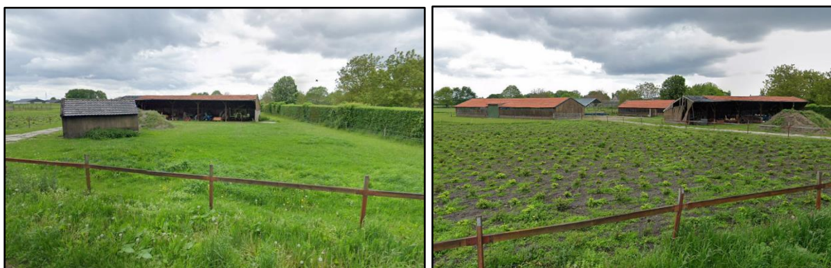
Afbeeldingen 15 en 16: te slopen bebouwing aan de Heibloemseweg
