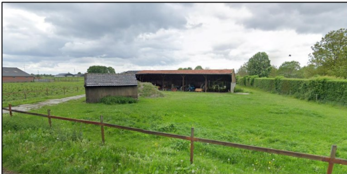
Afbeelding: aanwezige bebouwing die gesloopt zal worden.
