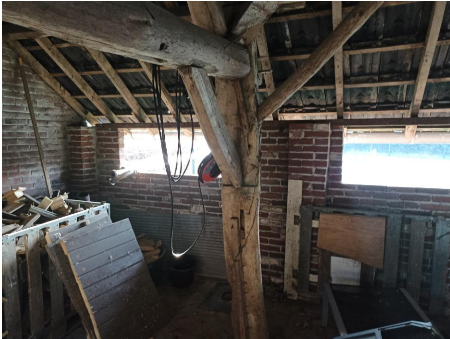
Figuur 4.2. De schuur met een enkelwandig pannendak en enkelwandige stenen gevels.
