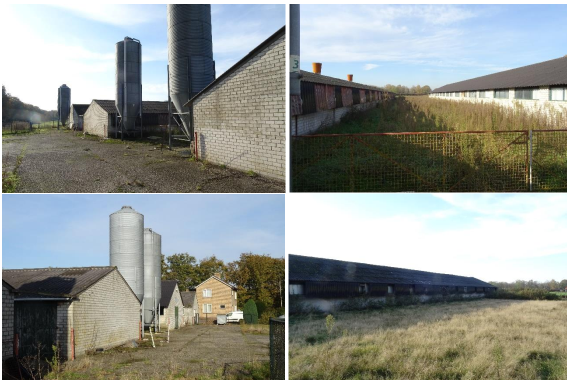
Afbeelding 3 t/m 6: De aanwezige te slopen stallen op de kavel. Bron: BNL advies, datum: 10-11-2021
