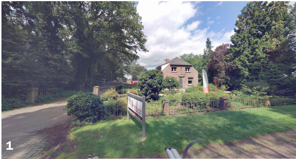
Aanzicht bedrijfswoning tegen bosrand - Cyclomedia
