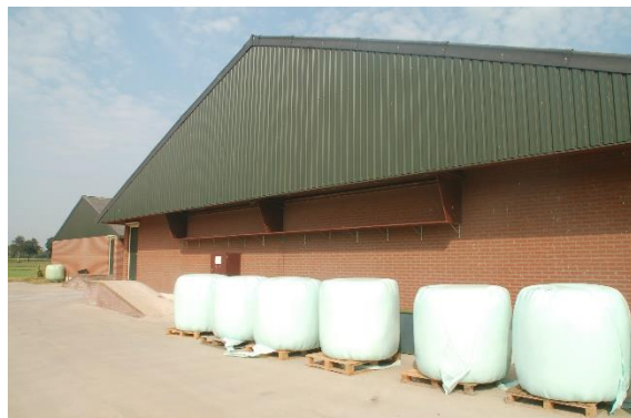
Afbeelding: achterzijde stal 2 en stal 3 met luchtinlaat
