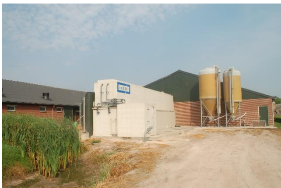
Afbeelding: achterzijde stal 1 met luchtwasser
