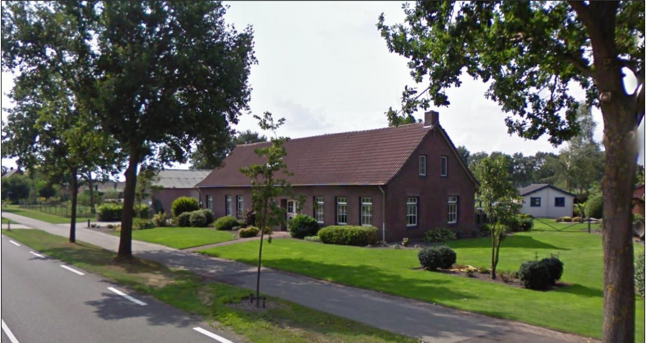
Figuur 2: De bedrijfswoning aan de Nederweerdijk 14 in Meijel
