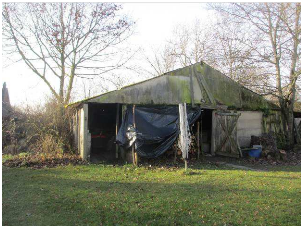
Fig. 5 De andere oude varkensschuur
