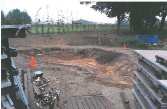
Afbeelding 5: saneringsput (bron: gemeente Peel en Maas)
