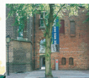
voortplein met centrale boom
