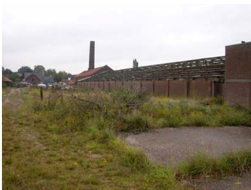
Foto 3: Noordwestelijk deel van het gebied
