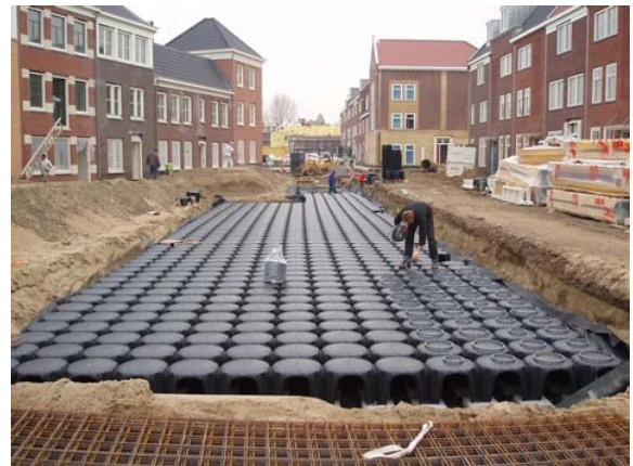
Aanbrengen van afstandhouders.
