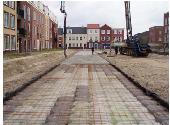
Betondek wordt gestort en verdicht..
