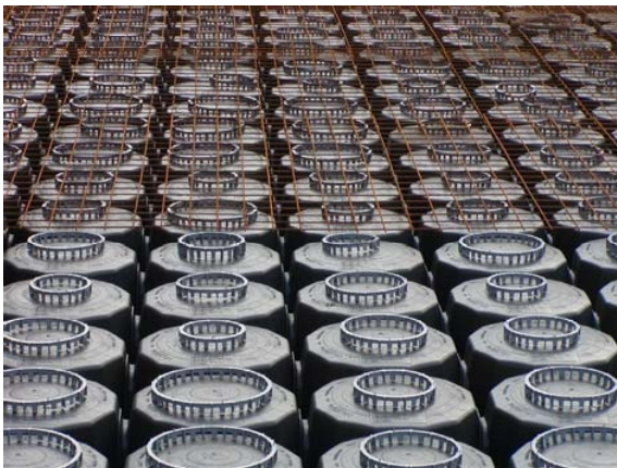
Wapeningsnetten worden geplaatst.
