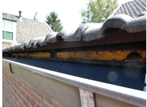
Figuur 17 Overgang muur naar dak
