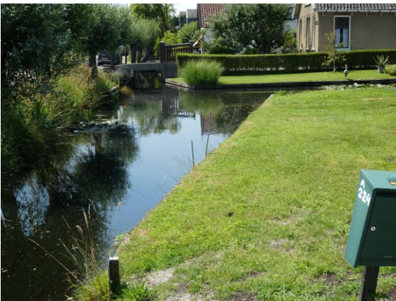
Figuur 6 Zuidzijde perceel met harde oevers
