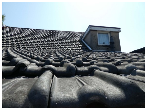
Figuur 15 Dakpannen zonder ruimte met een strakke aansluiting
