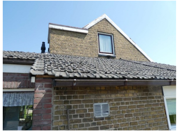
Figuur 5 Verloop van dakpannen en muur
