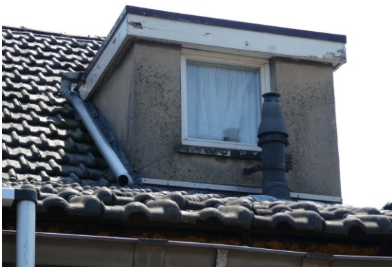
Figuur 18 Dakkapel met openingen in betimmering
