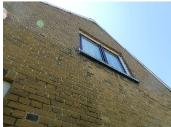
Figuur 13 Vrij hoge muur zonder stootvoegen
