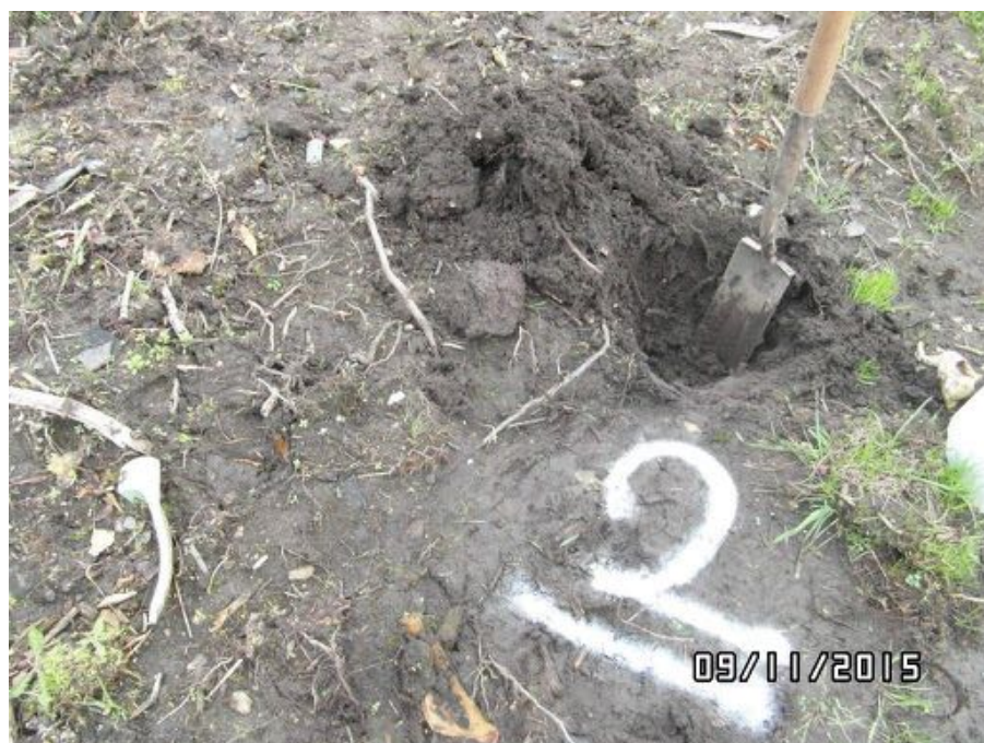
Plaats gat 2 voor indicatief onderzoek naar asbest in grond
