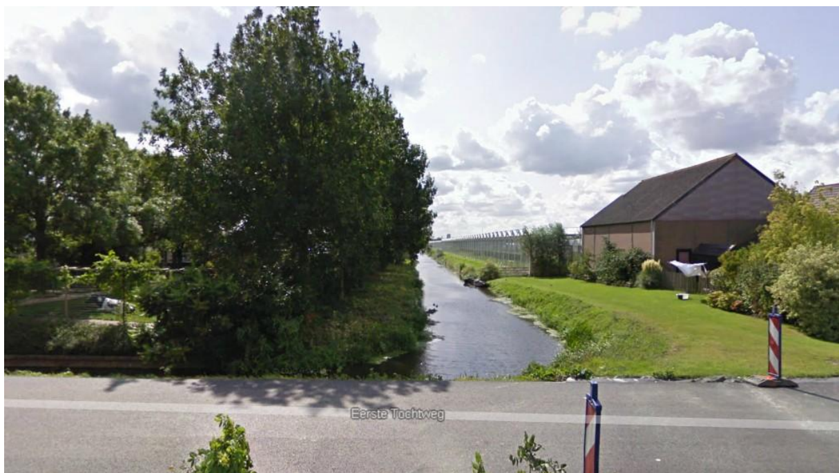
Figuur 3.2.2: Sloot tussen industrieterrein Hoogeveen en het nieuw in te richten industrieterrein Kandt (bron: Google maps)
