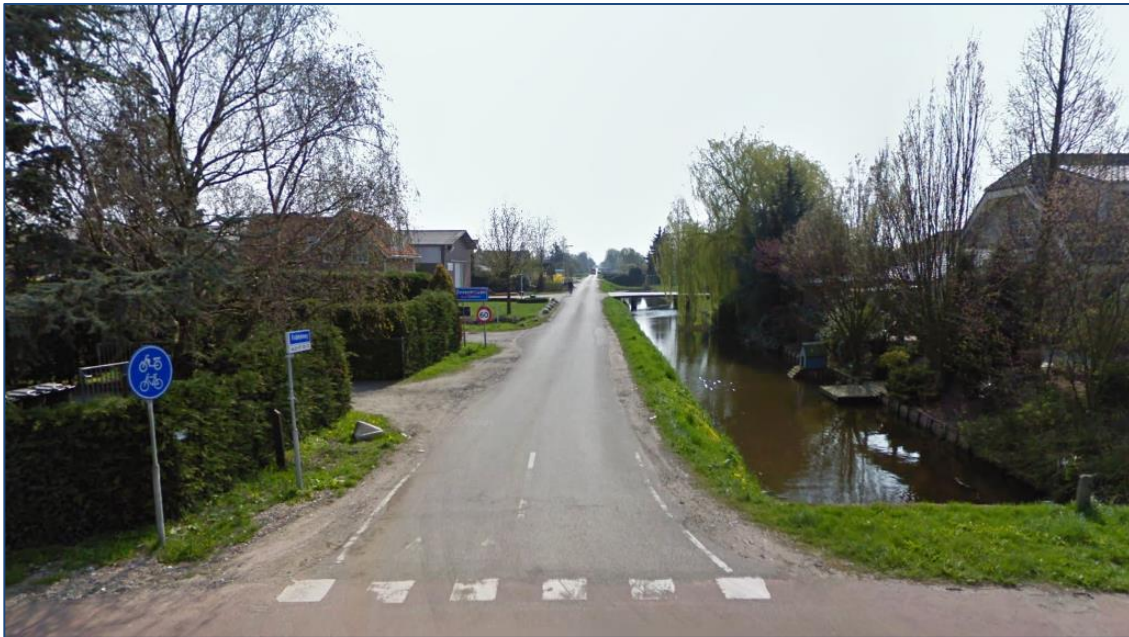
Afbeelding 2.2.: de Knibbelweg, gezien vanaf de kruising met de Noordelijke Dwarsweg. Bron: Google Streetview
