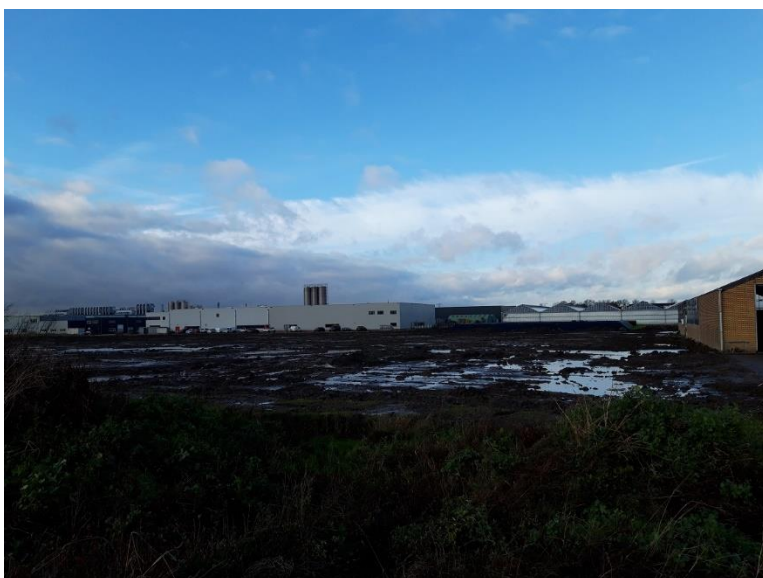
Foto F8 Van Dijk locatie voormalige kassen / bassins
