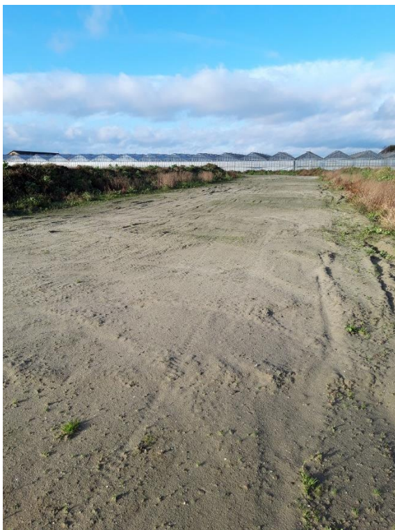
Foto F3 – zand voorbelasting
