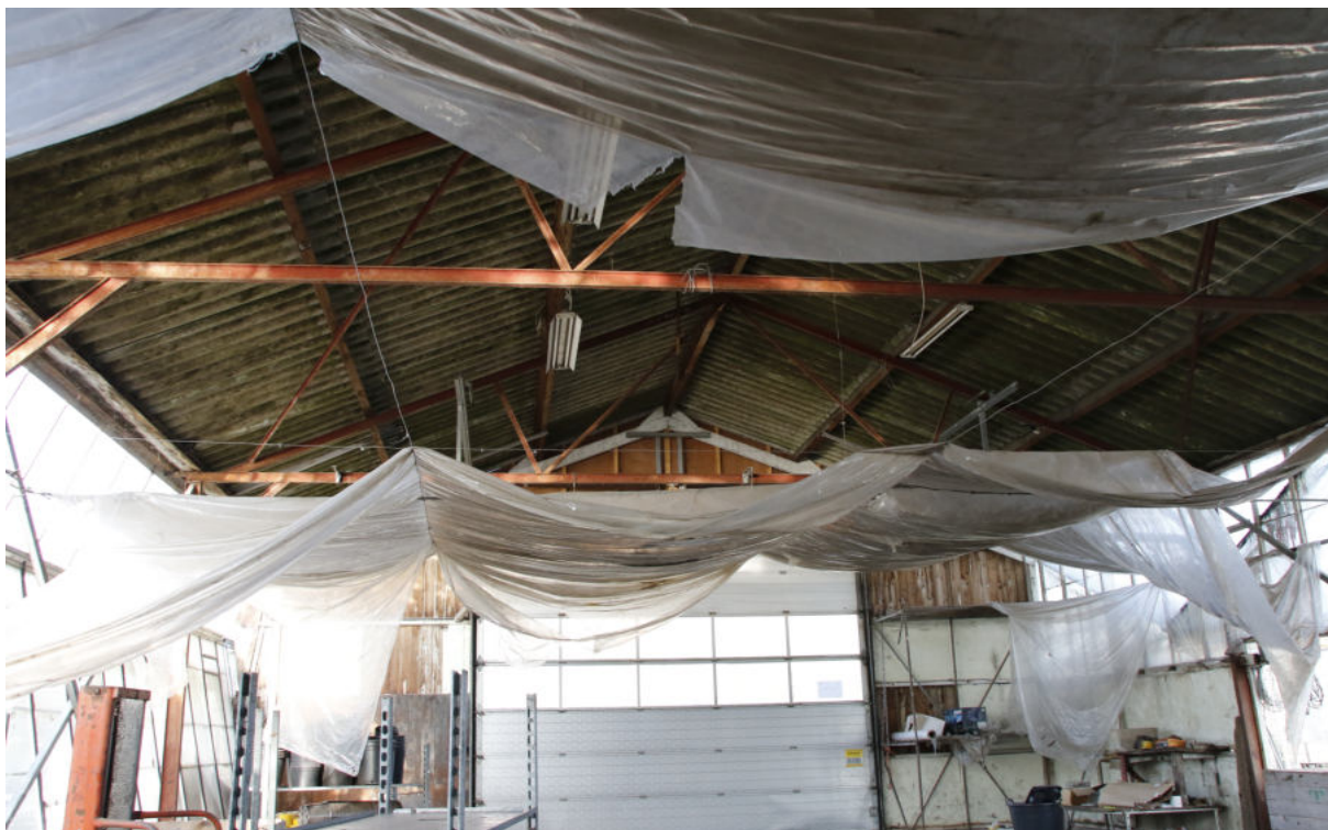
De binnenzijde van de schuur welke tussen beide kassen gelegen is. Deze schuur bevat geen gaten, kieren en holtes die geschikt zijn voor vogels en vleermuizen. Foto: K. de Vries | Ecoresult
