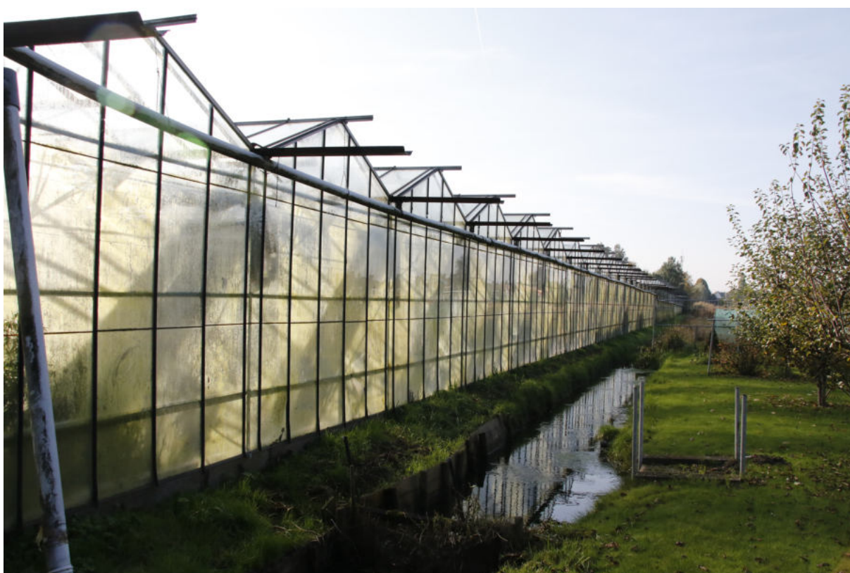
De noordwestzijde van de zuidwestelijke kas met de daarnaast gelegen watergang. Foto: K. de Vries | Ecoresult BV
