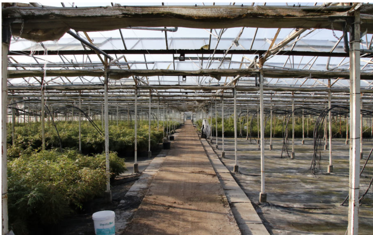
De binnenzijde van de zuidwestelijke kas. Er zijn nog veel bamboeplanten in de kas aanwezig. Foto: K. de Vries | Ecoresult BV
