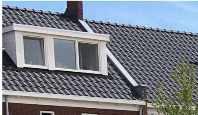
Dakkapel en opvallende gootlijn
