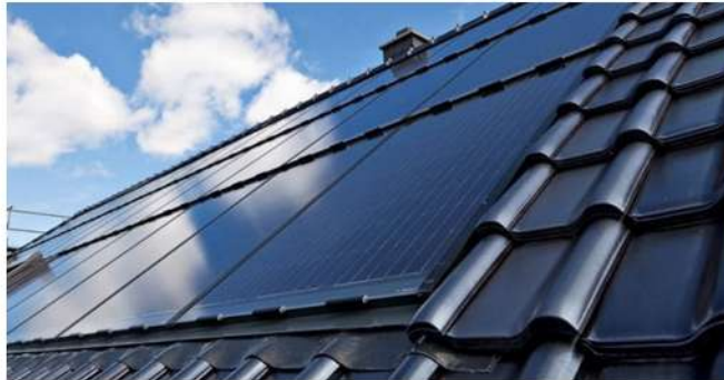
Geïntegreerde zonnepanelen in het dak, kleur op elkaar afstemmen
