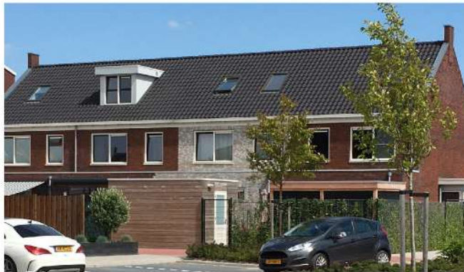
Af en toe een andere kleur metselwerk
