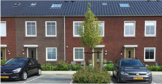
Af en toe een andere kleur metselwerk
