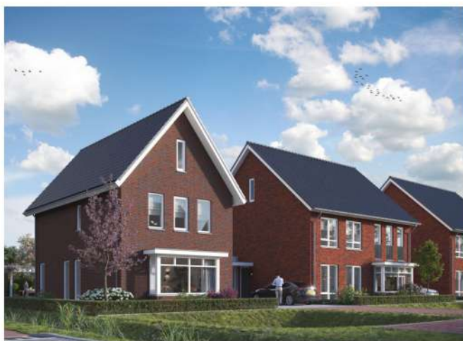
Verschillende kleuren metselwerk
