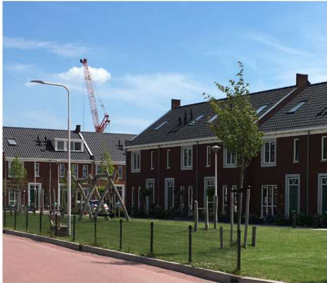
Doorsteken van de scheidingsmuur door het dak als accent in de rij
