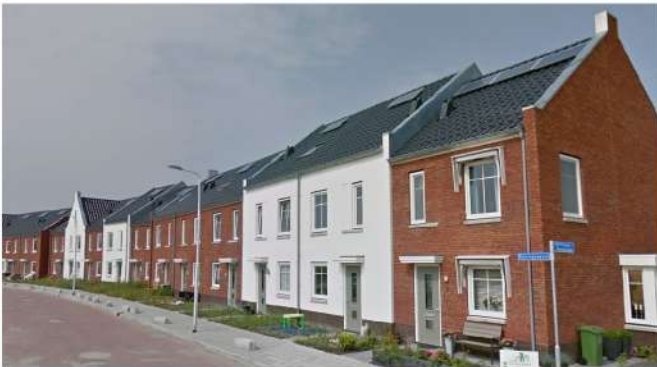
Doorsteken van de scheidingsmuur door het dak en kleuraccenten
