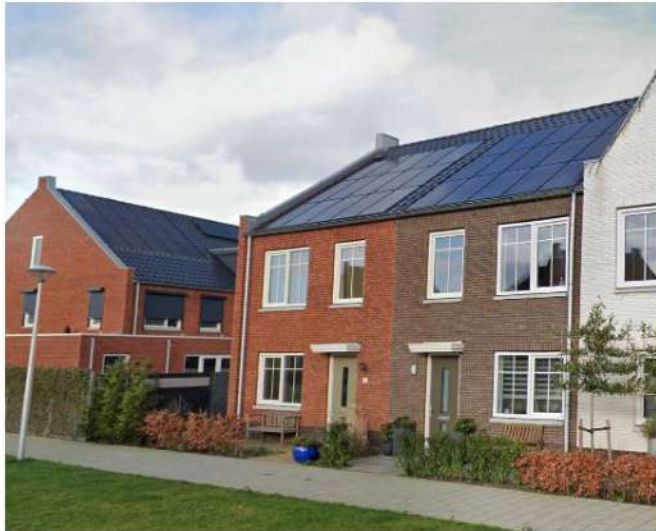
Zonnepanelen in een donker dakvlak
