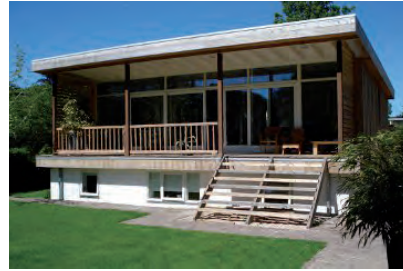
plat dak met wateropvang
