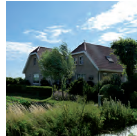
grastalud met haag
