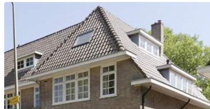
Steile pangedekte daken met gemetselde schoorsteen
