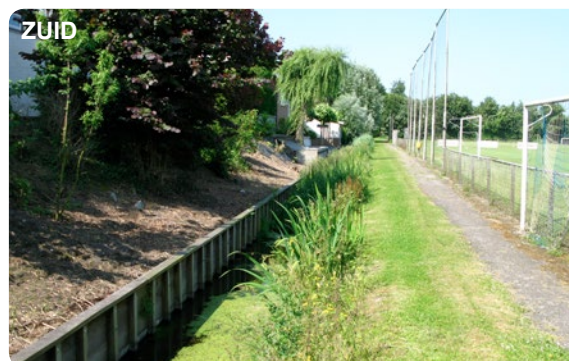
Zicht langs de sloot onderaan de dijk: de sloot onder aan dijk vormt een duidelijke grens tussen de bestaande dijkbebouwing en de lager gelegen polder.
