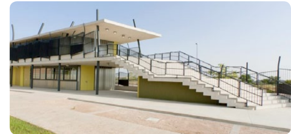
Clubgebouw in twee lagen en markante opgang
