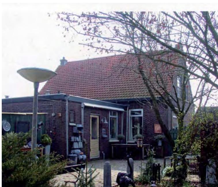
achterkanten woningen Stevensstraat
