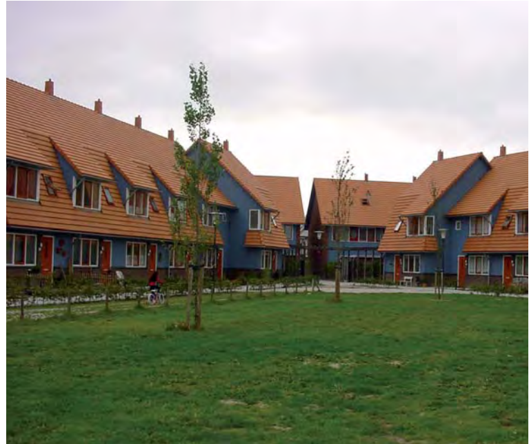
dakkapellen als onderdeel van de kap.
