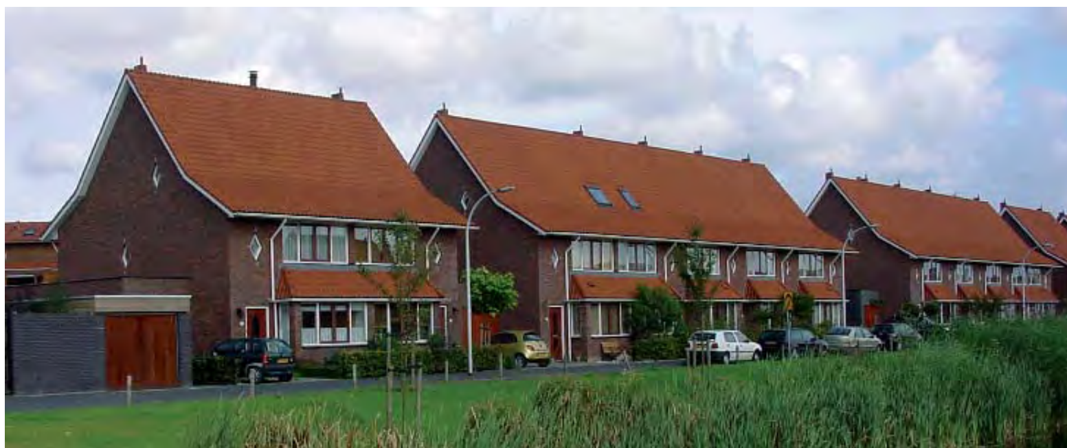
lage goot en dakkapellen naar de straat met een groene voortuinen
