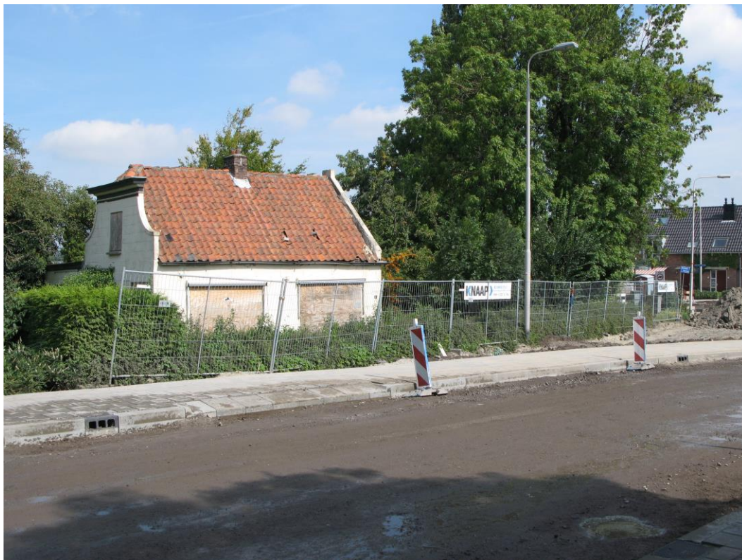
Bestaande woning aan de Noordelijke Dwarsweg 5, Zevenhuizen.
