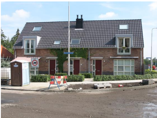
Recent gerealiseerde nieuwbouw aan de Burg. Klinkhamerweg/ hoek Noordelijke Dwarsweg.
