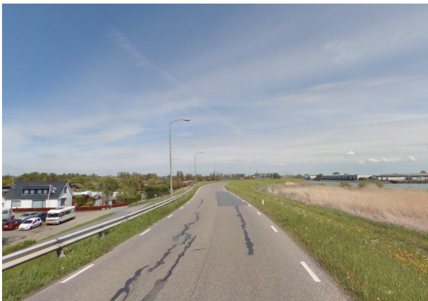
Figuur 3.2 De Schielands Hoge Zeedijk Oost vanaf de zuidzijde (bron: CycloMedia)
