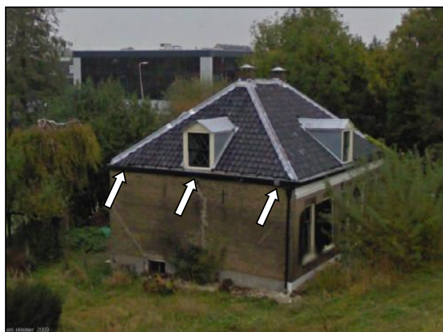
Foto 6. Potentiële invliegopeningen voor vleermuizen naar spouwmuur Dorpsstraat 31
