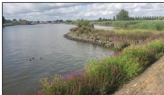
Foto 3. Ruig begroeid dijktaalud ter hoogte van te plaatsen damwand, met grote kattenstaart, riet, wilg en spindotterbloem.
